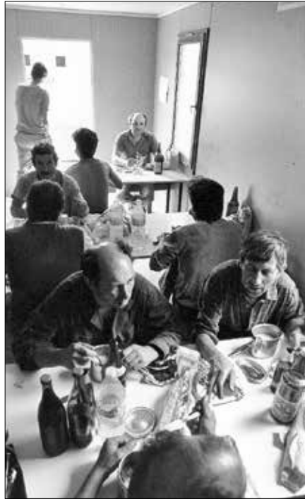
Cantine sur le chantier de l'autoroute de contournement en 1987, Interfofo.
